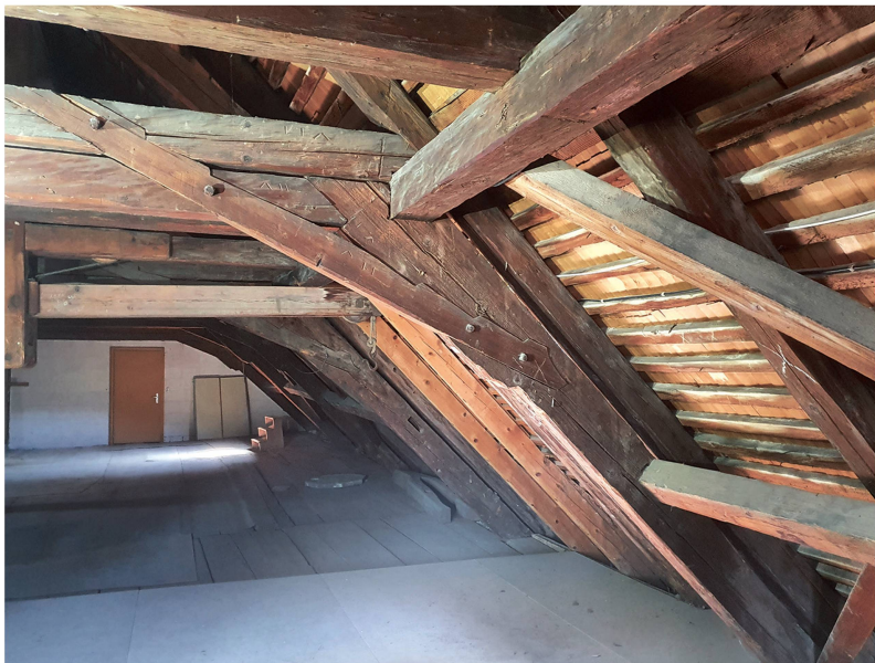
Abb. 8: Chur, Hof, Bischöfliches Schloss, Nordtrakt. Liegender Dachstuhl von 1639. Die an der Stuhlsäule, dem Spannriegel und dem Kehlbalken angeblattete Kopfstrebe zeigt die für diese Zeit typische Formung mit Haken und schnabelförmigem Ende. Blick gegen Osten.
